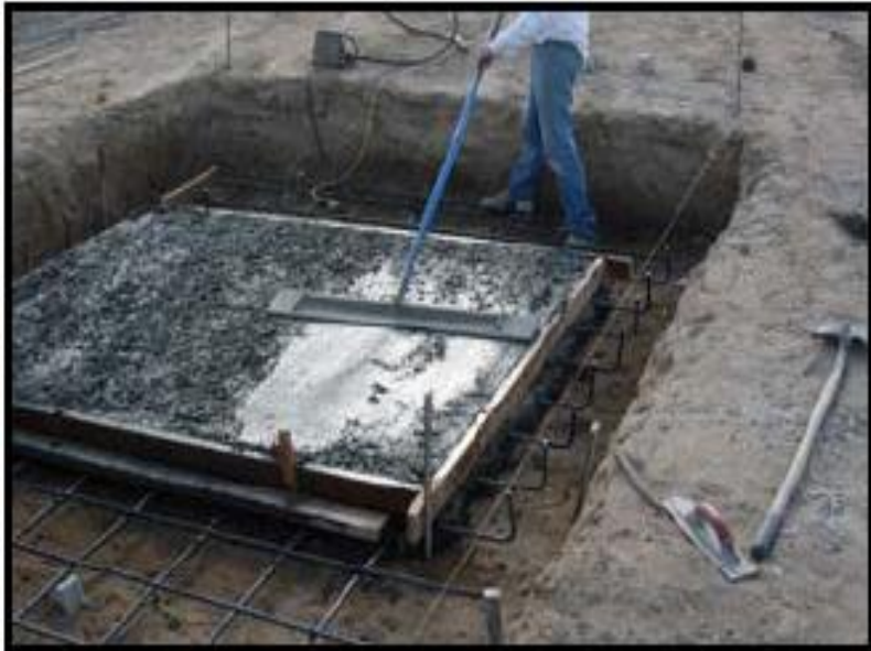
First Pour of Concrete (min 7"/192mm)
