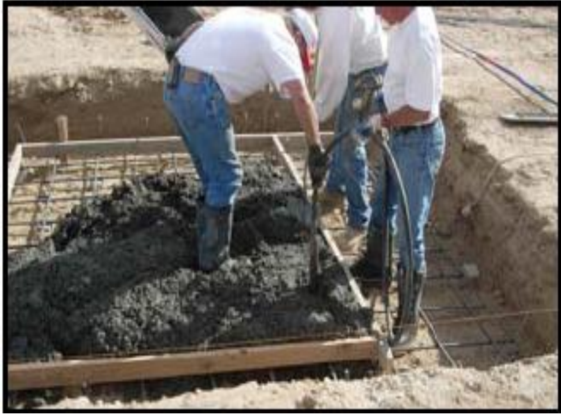
First Pour of Concrete (min 7"/192mm)
