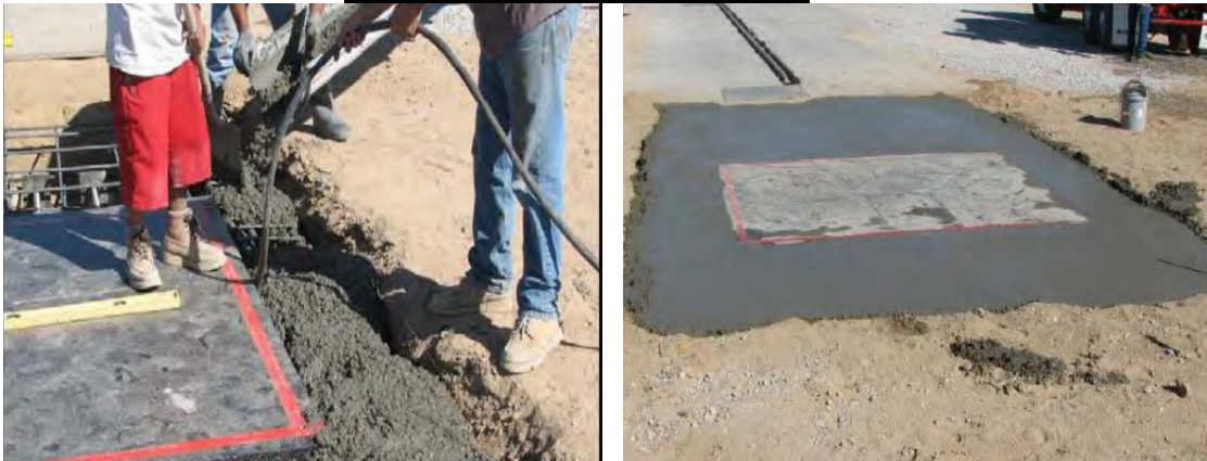
Picture 9 - Final Concrete Pour
